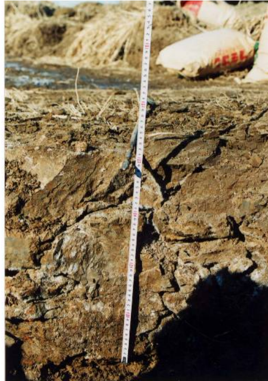
無散布域での掘削断面 (凍結厚 50cm 程度であった)
