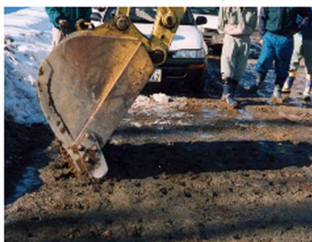
ピバメルト散布 （注入方式 30L/m 2 ）
