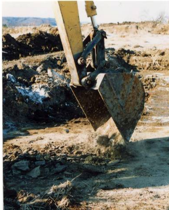
無散布域での掘削 (掘削は困難であった)
